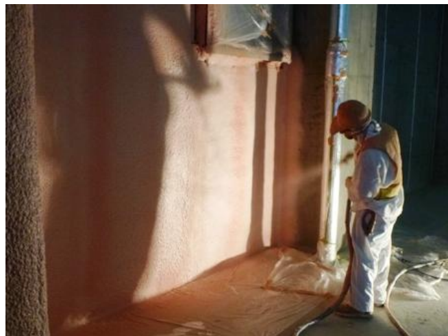
図1 施工マニュアルの現場試行（吹付け施工）
