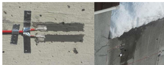
図3 コンクリート表面の濡れ測定
