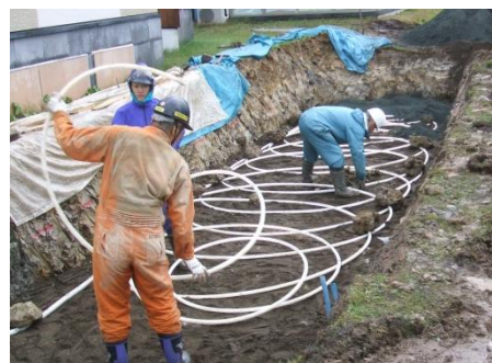
図3 水平探熱式ヒートポンプ（探熱管設置）
