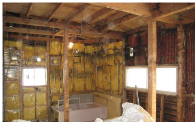
写真1 グラスウール採取現場の例（昭和49年築）
