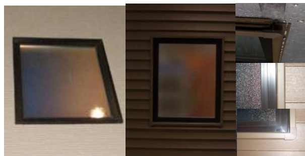
図1 断熱改修試行（窓周り）
