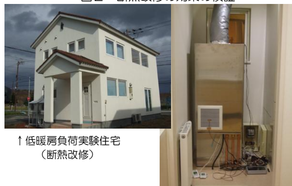
写真 換気廃熱回収ヒートポンプ暖房の実験
