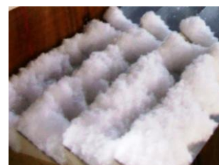
写真3 庇上の堆積状況
