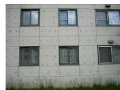
(b) アンカ箇所損傷
