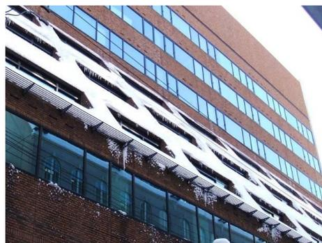
写真1 外壁における積雪と氷柱の発生
