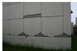
(a) 下地材の損傷
