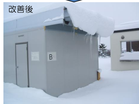
写真1 通気層と断熱改善による積雪障害改善効果
