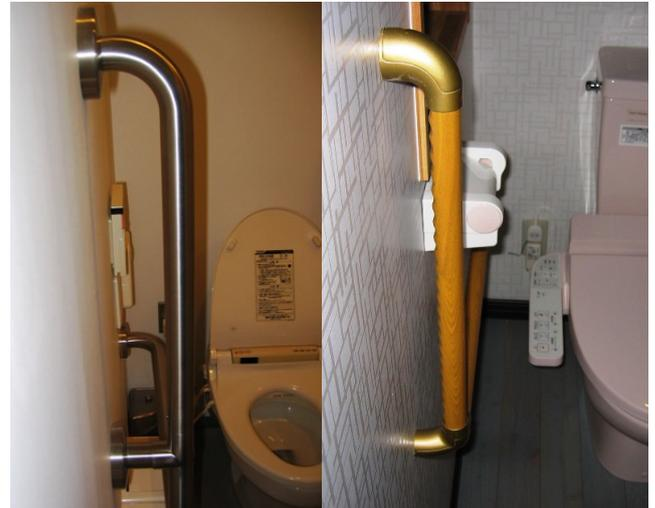
写真1 現状の手すりの取り付け位置
