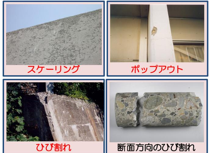
図1 コンクリートの劣化事例
