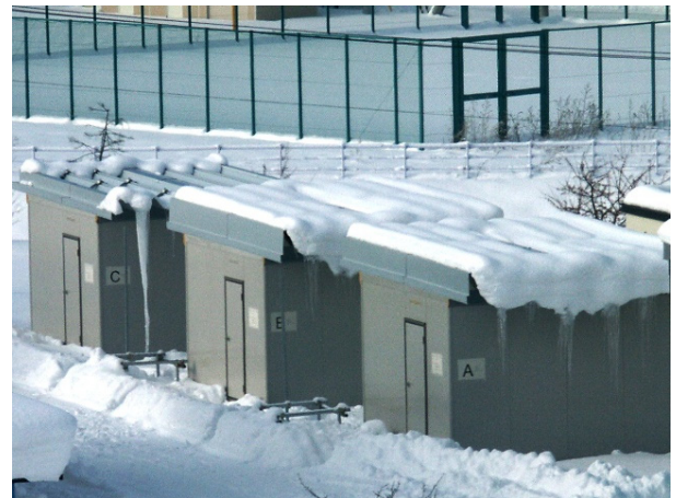
写真3 金属折板屋根の仕様を変えた建物による比較実験
