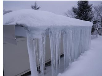
写真1 実験建物の氷柱と氷堤
