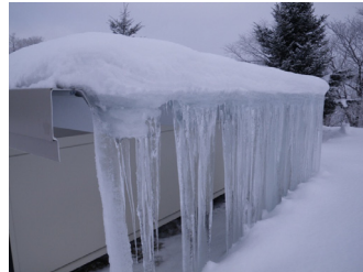
写真1 実験建物の氷柱と氷堤
