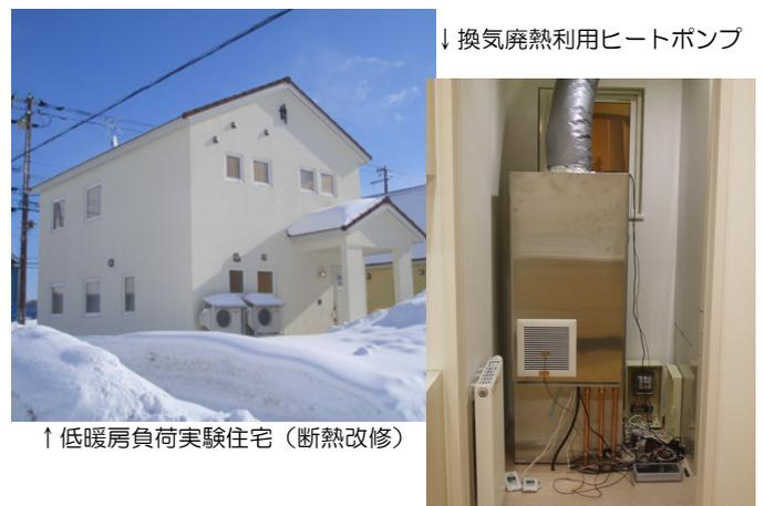
図2 換気廃熱利用ヒートポンプ暖房システム実験
