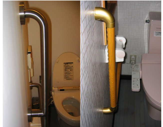
写真1 現状の手すりの取り付け位置
