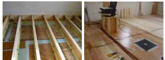
写真1 実験住宅棟における実験 (配管敷設状況 床仕上げ状況)
