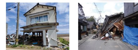
地震津波による住宅被害
