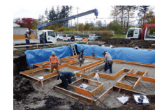
実験棟の建設状況
