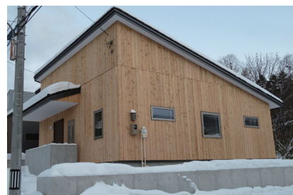
木外装防火外壁を採用した住宅
