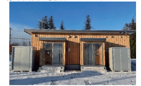
木造応急仮設住宅の実験棟
