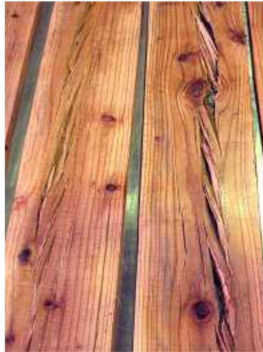
写真 4 - 1 9 水蒸気による破裂の例
