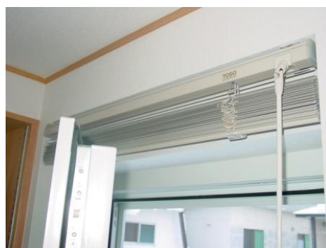
内開き時にブラインドの溜まり部分が開閉の支障とならないようにする。
