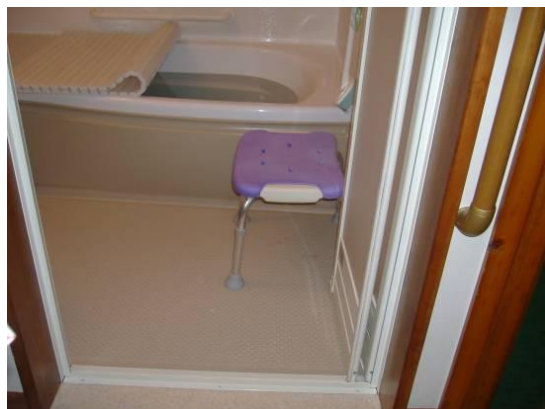
写真10 脱衣室と浴室のフラット化
