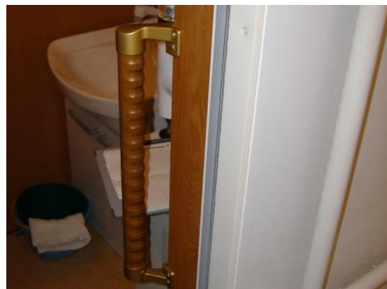
写真11 浴室出入り用手すり
