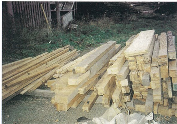
住宅から排出された解体木材
