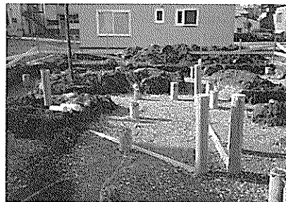
写真2-6 埋設給気管の施工
