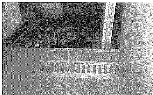
写真3-12 現場製作床面開口ガラリ
