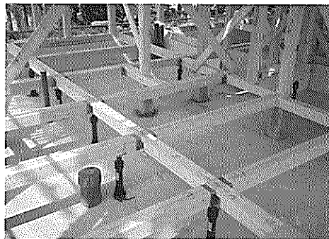
写真2-3-1 プラ束を使った開放的な床下
