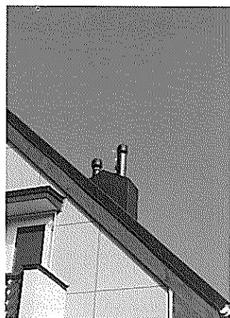
写真3-6 排気トップの例 (スウェーデン製)
