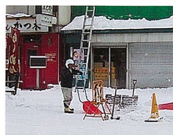
流雪溝に雪を入れる様子 (旭川市)
