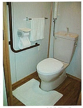
トイレについているL字型の手すり
