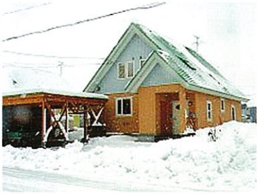
屋根に雪が積もりにくい落雪屋根住宅
