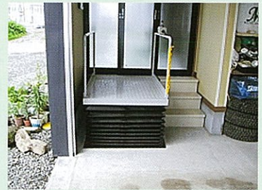
玄関横の車庫についている段差解消機
