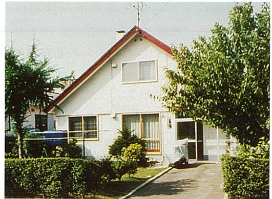
ブロック造住宅
