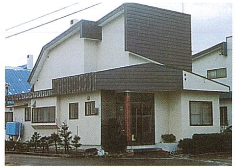
変形屋根の住宅
