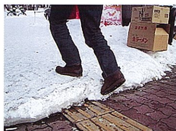
ロードヒーティングの境目にできた段差
