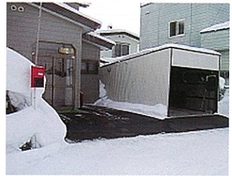
ロードヒーティングで玄関前の雪を溶かしている家
