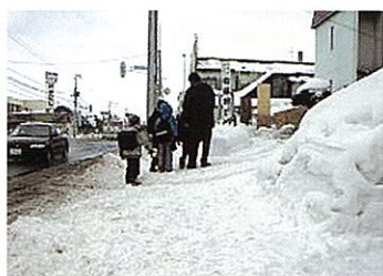
車道に向かって傾斜している歩道
