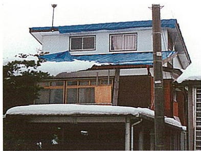
瓦屋根の雪を滑りやすくするためのビニルシート
