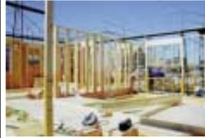
土台の上に柱を建てます。次に、2階の床梁を付けます。                              |
