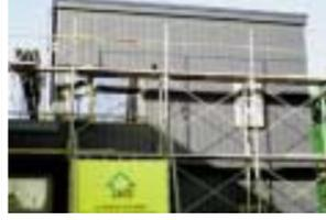
内部仕上げと同時に外部の仕上げを行います。透湿防風層を張り、通気層をとってサイディング等で仕上げます。 | 12.
