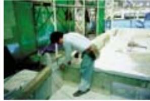
土台を基礎に取り付けます。土台周りはぬれてくさりやすい所なので、必ず防腐処理をした木材を使います。      | 4.
