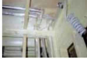
給水・給湯用の配管や電気配線工事を行います。                                | 8.
