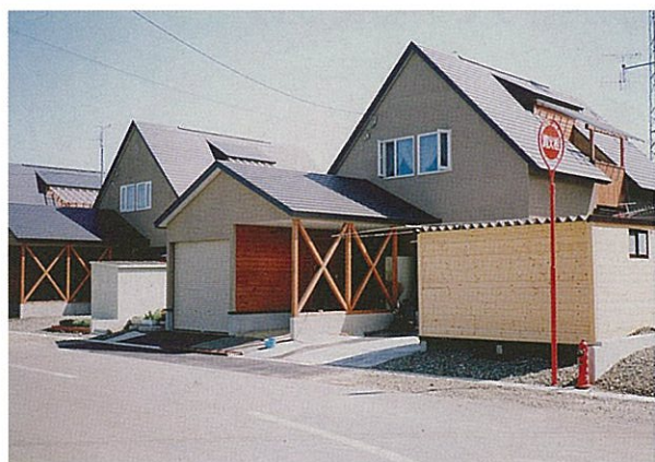
車庫を建物と一体的に作った街並み(富良野市)
