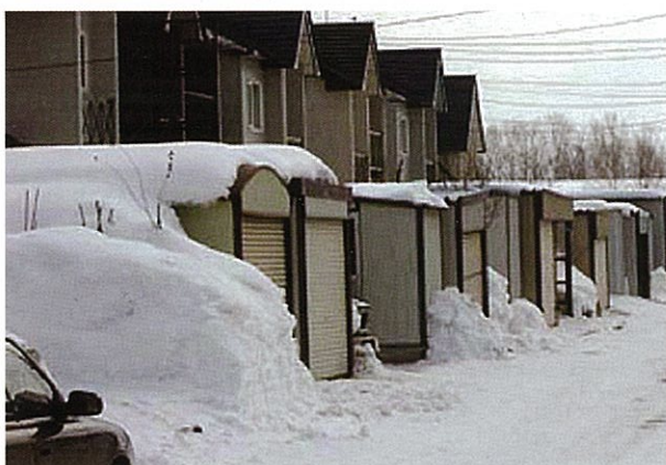
一家に2台分の車庫がある街並み(旭川市)
