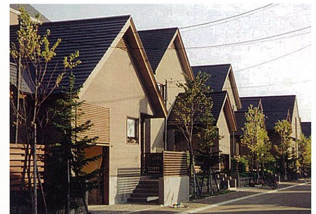
屋根・壁の素材や色、壁面の位置が揃っている(札幌市)
