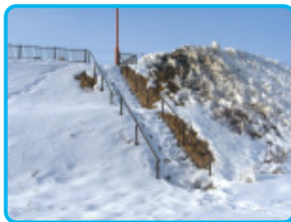
高台への避難階段の積雪
