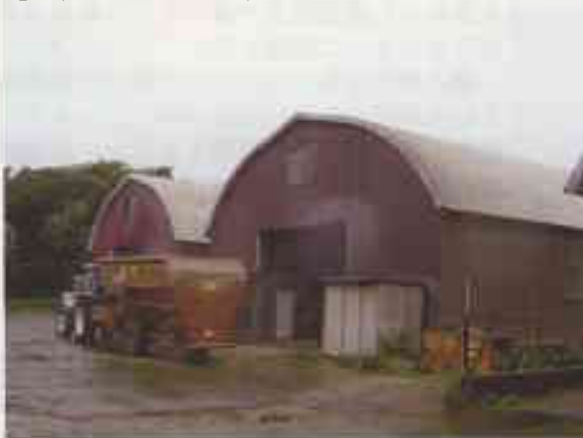
写真2 TMR 飼料倉庫群
