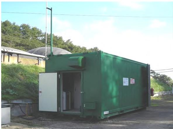
図 1 余剰バイオガス精製圧縮充填装置
