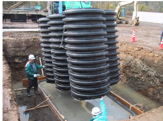
写真1 浄化槽布設作業
