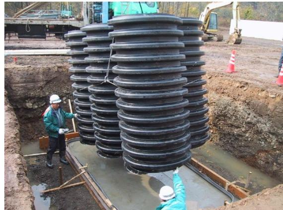
写真1 浄化槽布設作業
