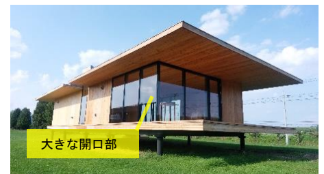
CLT実験棟「Hokkaido CLT Pavilion」
