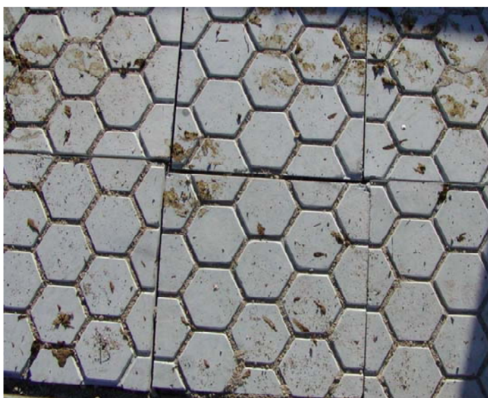
写真2 インターロッキング目地
