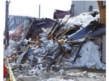
積雪期の降雨による影響で倒壊した建物（北海道内）
