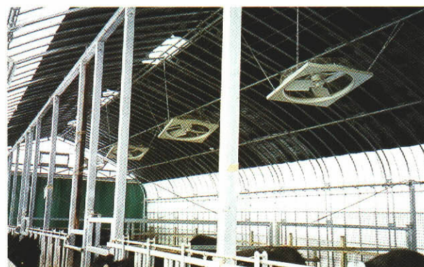
▲写真4-4 直下型換気扇を備えたビニールハウス牛舎
