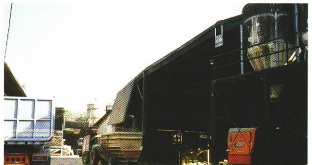
▲写真2-7 屋根付き飼料調製場の両側に飼料タンクが併設されている
