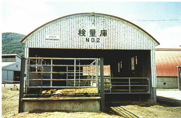
▲写真2-5 検量庫に搬出入施設を併設すると便利だ
