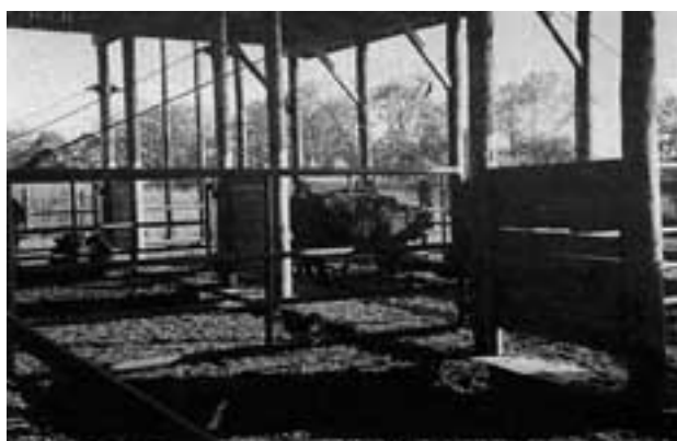
写真8-10 牛房内（固定仕切り、すべり止め設置）
