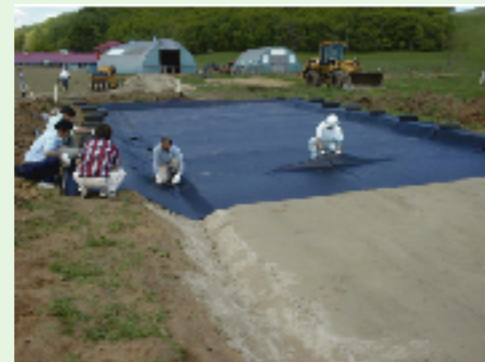
シート利用ふん尿堆積場の現地農家での実証造成
