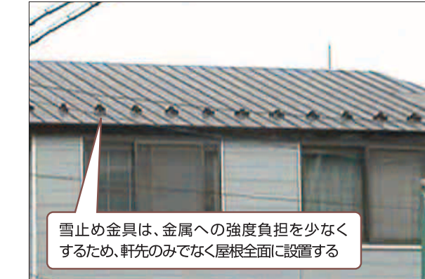
■写真:4 不適切な雪止め金具の設置状況
