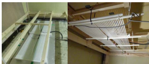
図2 埋設前の樹脂製放射パネルの外観
