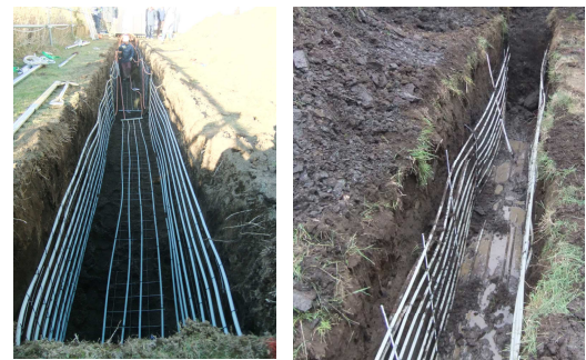
図1 樹脂製柵状熱交換器の概要と外観
