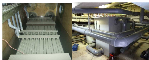
図3 給湯予熱システムの概要図と外観（登別温泉）
