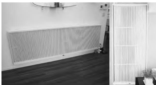
図 プラスチック製放射放熱体の外観
