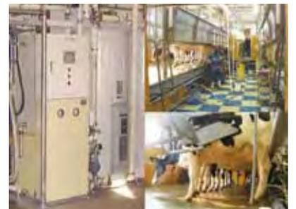
写真③ 牛乳熱利用ヒートポンプ給湯
