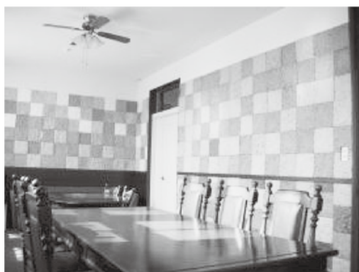
内装壁面に試験施工された軽量タイル
