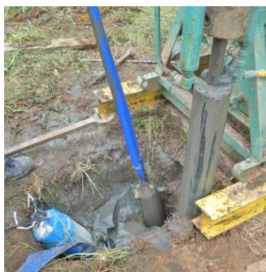
垂直埋設管の施工の様子
