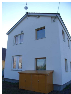
実験住宅の外観
