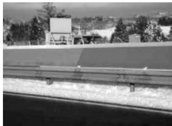
図4 中央分離帯積雪防止板の設置状況
