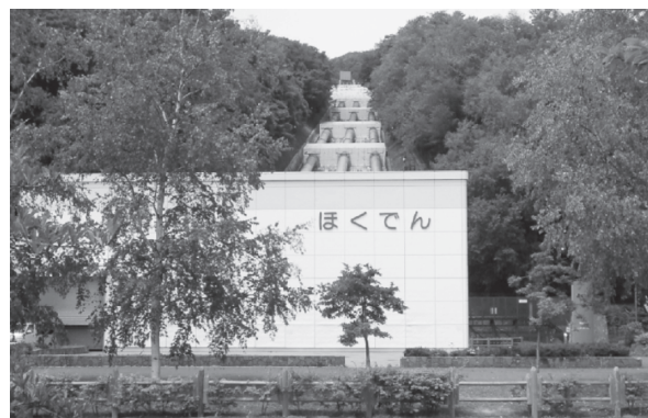
図10 北海道電力（株）藻岩発電所
