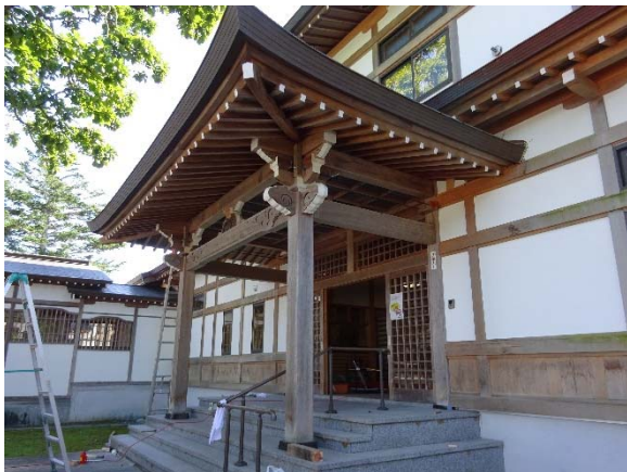
写真 5.3.33 社寺建築の玄関部分の補強
