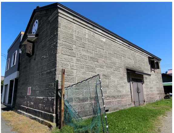
写真 5.3.19 文化財指定された比較的古い組積造の倉庫
