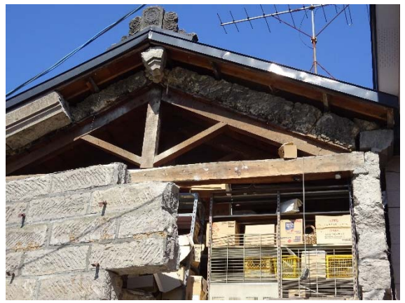
写真 5.3.18 写真 5.3.17 の小屋組
