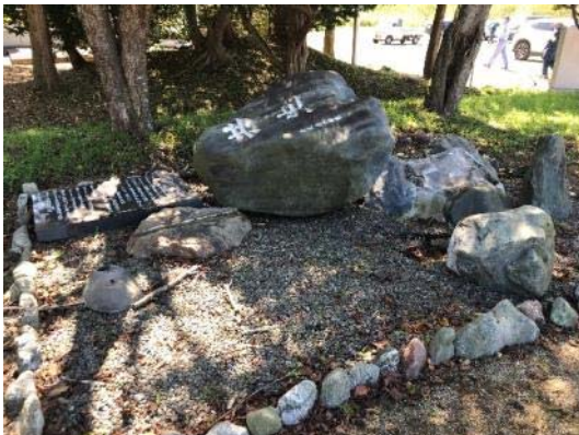
写真 5.2.13 建築物 B 付近の工作物の破壊状況 (上部が東側へ転倒)
