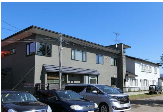
写真 5.2.18 外観上無被害に見受けられる住宅
