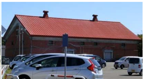
写真 5.2.21 外観上無被害に見受けられる組積 造による大規模倉庫
