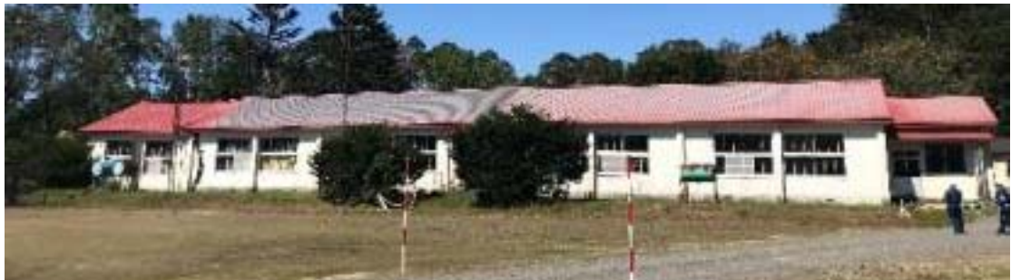
写真 5.2.3 旧小学校の校舎 A 全景
