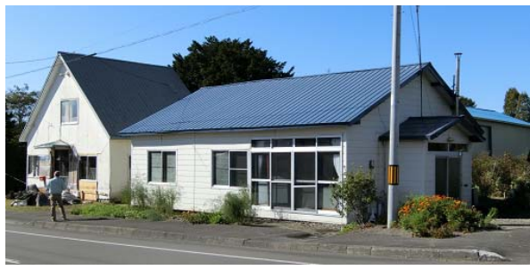
写真 5.3.40 外見上無被害に見受けられる住宅
