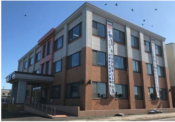
(a) 町役場庁舎の全景
