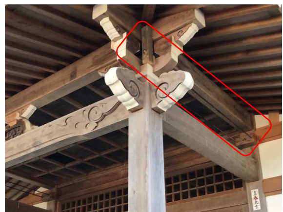
写真 5.3.34 写真 5.3.33 の補強部分
