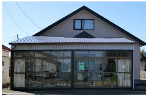
写真 5.1.15 ほぼ無被害のように見受けられる比較的新しい 2 階建ての店舗併用住宅
