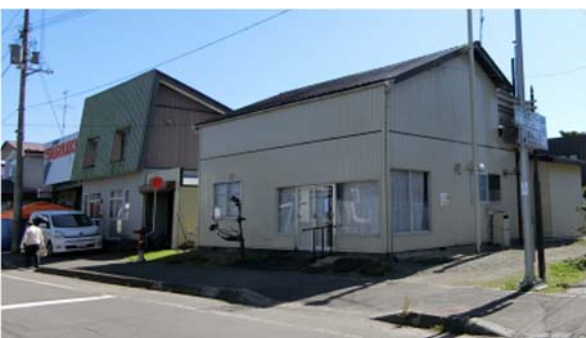
写真 5.2.20 外観上無被害に見受けられる店舗 又は店舗併用住宅
