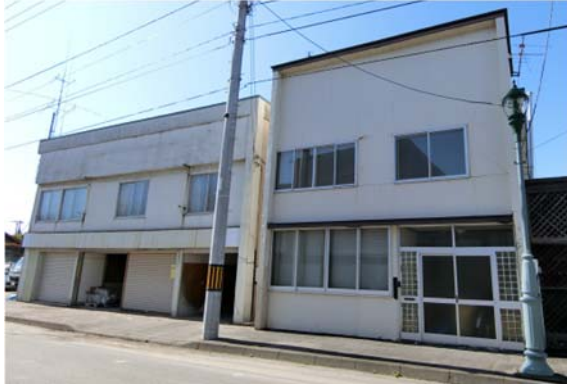
写真 5.3.23 間口に壁の無い木造モルタル 2 階建て
