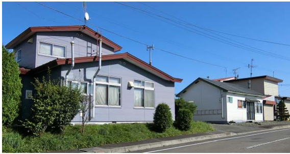
写真 5.3.39 外見上無被害に見受けられる住宅
