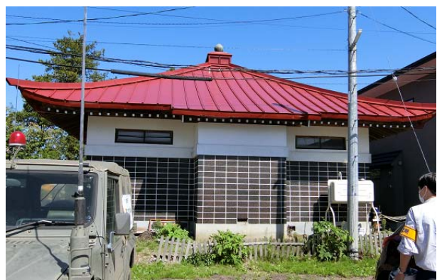
写真 5.2.19 外観上無被害に見受けられる寺社 建築
