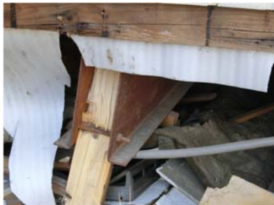
(d) 2階床を支持する鋼材
