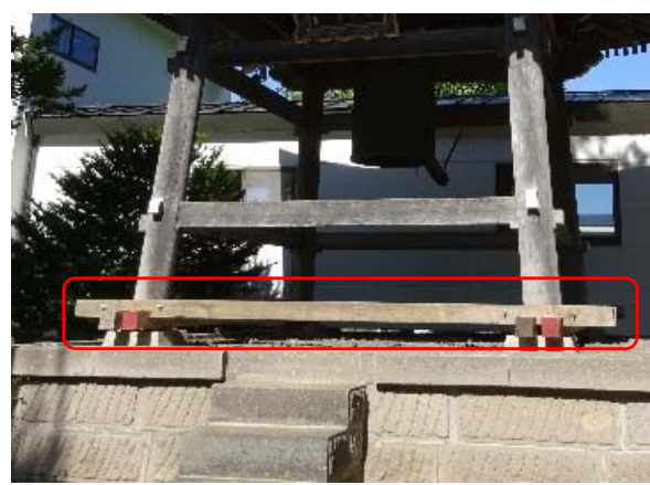
写真 5.3.36 写真 5.3.35 の補強部分
