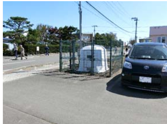
(b) 地震計の設置状況②
