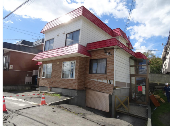
写真 5.2 地盤変状により基礎・上部構造ともに損傷したように見える戸建住宅
