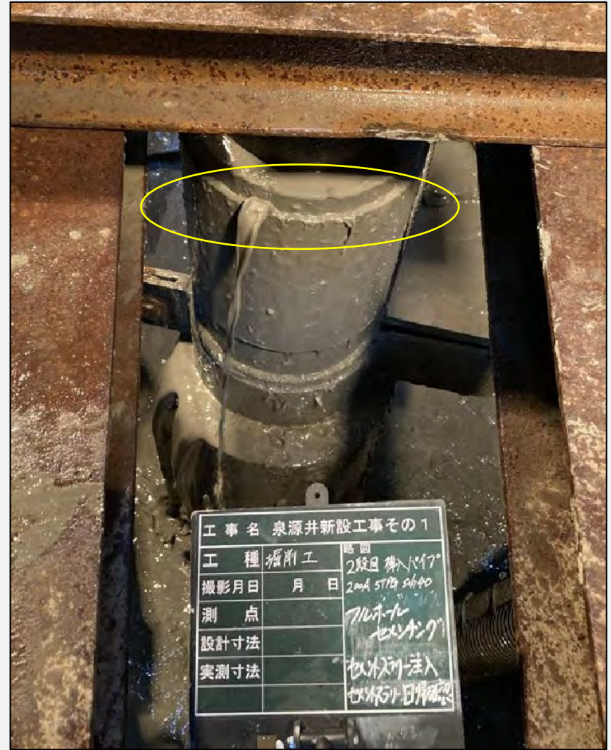
【STPG200A環状部】 セメントスラリー回帰確認
