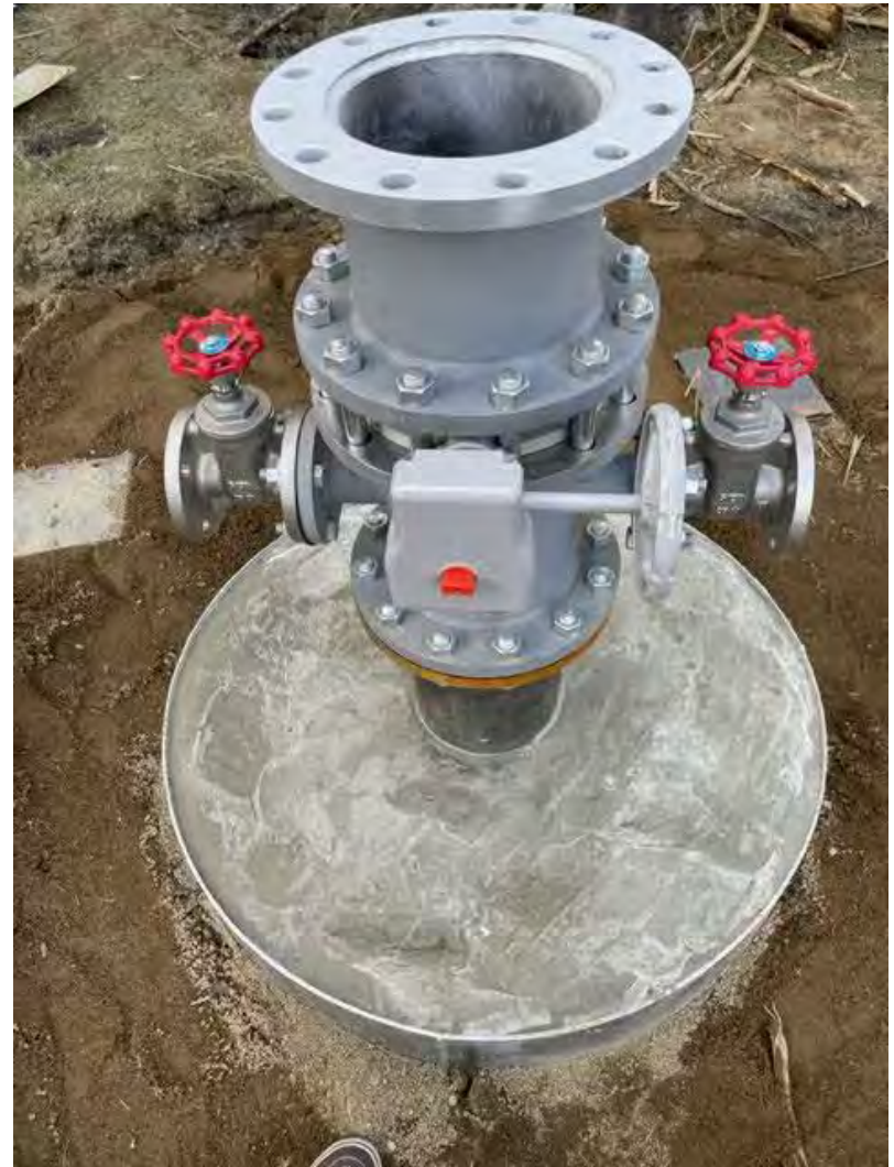
・坑口装置設置
