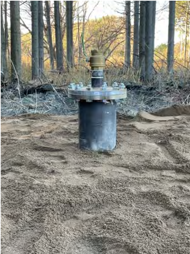
・CSG立上げ、仮バルブ設置
