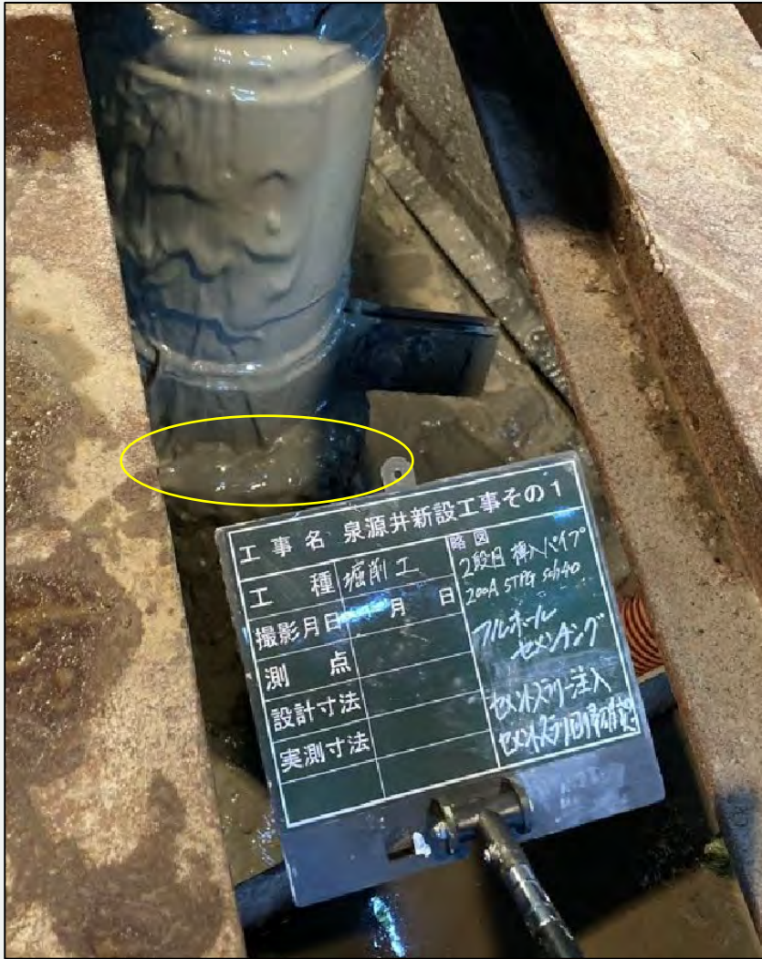
【VP250環状部】 セメントスラリー回帰確認
