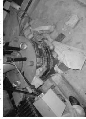
2F口元の変状況 (OPの抜け上がり)
