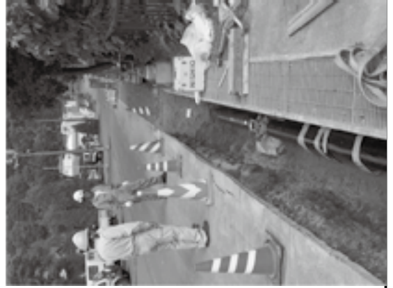
地熱水送湯管敷設工事 GNG125A・1,684m 9.8℃仕様
