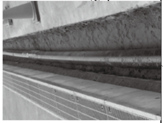
地熱水送湯管敷設工事 GNG125A・1,684m 9.8℃仕様
