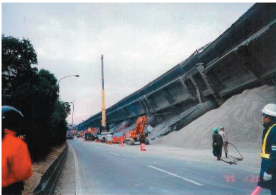
写真1 兵庫県南部地震（道路・橋梁被害状況）
