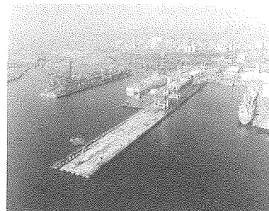
Photo.2. 施工中のマニラ港の棧橋延長部
