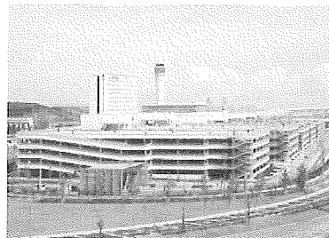
Photo.3. 完成した中部空港立体駐車場
