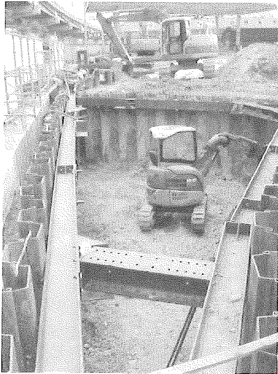
汚染土の掘削除去
