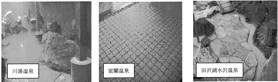
図5 温泉での施工状況（支柱の基礎部（置換え）、タイル目地（新設）および鉄平石目地（補修））
