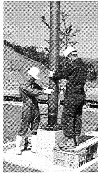
7”ケーシング(1000PSI) 挿入作業中
