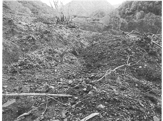
写真17 写真15左側の波状に堆積した土砂 ブロックが前方(写真右側)へ転倒.
