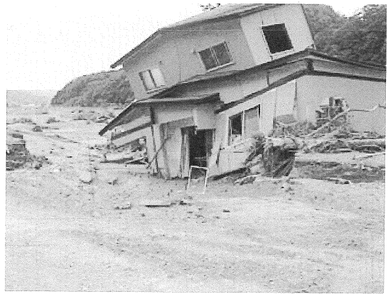
写真3 洗掘による家屋の倒壊
