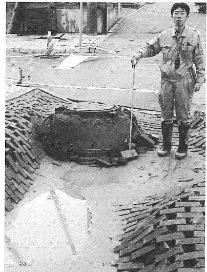
写真25 埋め戻し土の沈下によりマンホール が相対的に30cm抜け上がった
