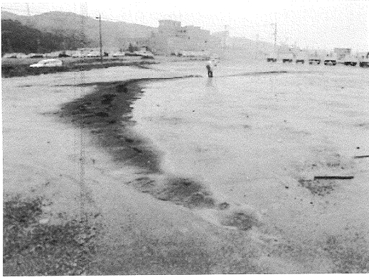
写真28 浦河の臨海埋立地での亀裂に沿った噴砂列 地盤は海側(写真右)に側方移動した
