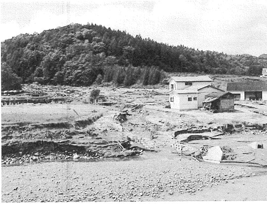
写真6 比宇川の洪水(手前)と背後の沢(左奥)からの土砂流による被害
