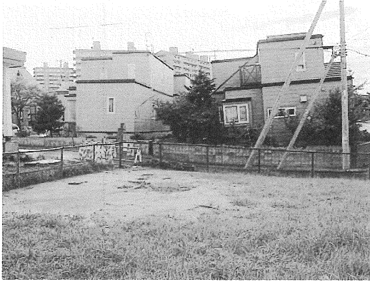
写真22 札幌市清田区美しが丘の住宅(右)が傾動 手前の空き地では大量の噴砂が生じる。
