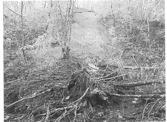
写真9 比宇川支沢の斜面表層崩壊
