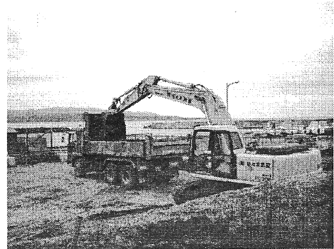
処理土搬出、最終処分
