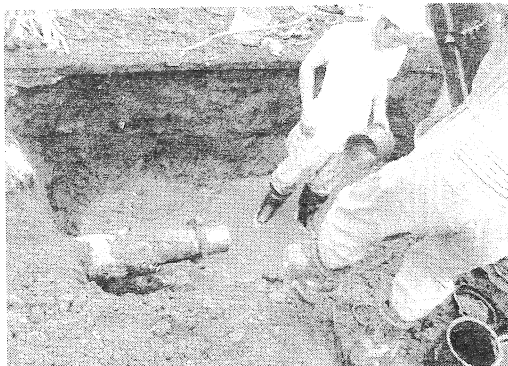
道々洞爺湖登別線本管漏湯修理状況
