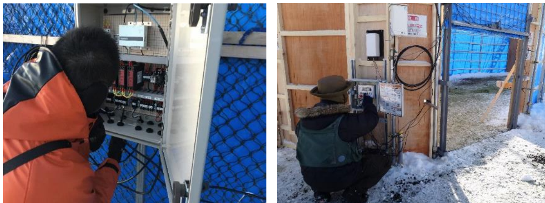
写真 1-4 ICT 技術を活用した制御部の設置例
