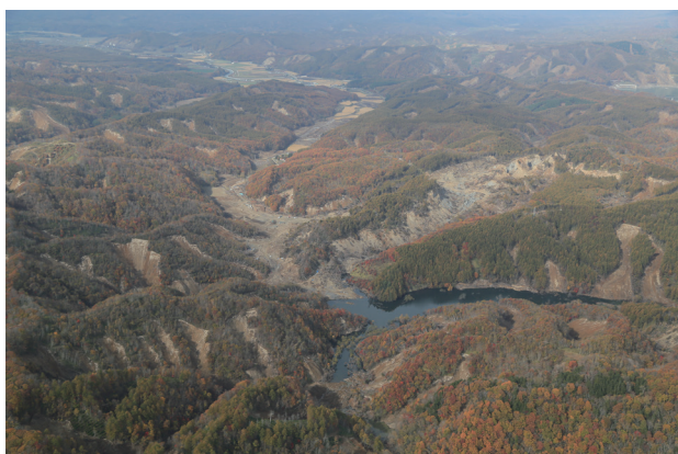
写真3: 日高幌内川をせき止めた岩盤地すべり ((株)シン技術コンサル 2018年10月26日撮影)
