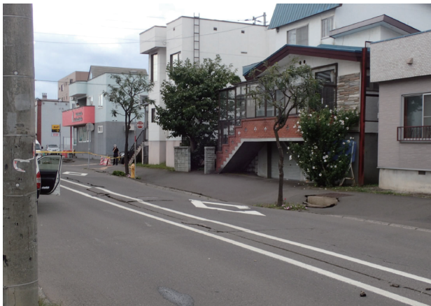
図 15 札幌市北区北 35 条～北 38 条にかけての地盤変状状況(国際航業 西村智博 撮影)
