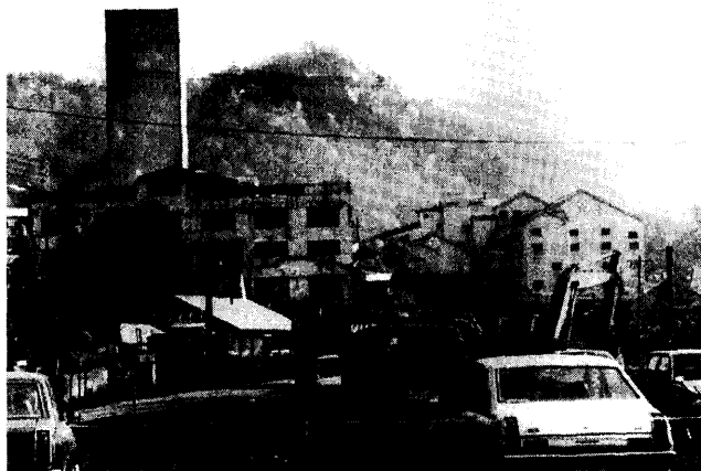
第37図 真谷地炭鉱、後方は立坑 —安藤文男写真集「夕張を見つめて半世紀」、1998より—
