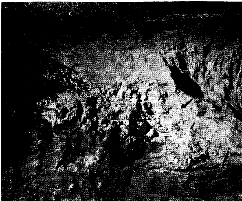
登別層〔No〕と支笏浮石層〔Sp〕（アヨロ附近道路切割） 登別層を支笏浮石層が不整合におおい、支笏浮石層中にはかなり大きな 破碎帯がみられる。
