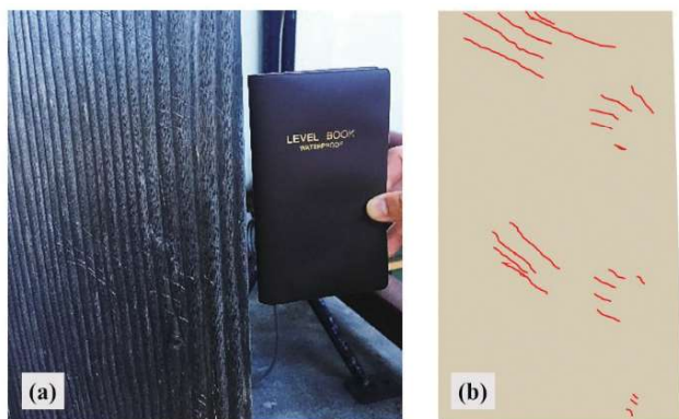
図4 (a)アライグマが建物に侵入した際の爪痕が、柱や壁に残っている。(b)(a)の柱に刻まれた爪痕の模式図
